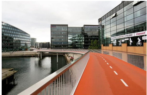
Abb. 6-2 Kopenhagen: neue Velobrücke
