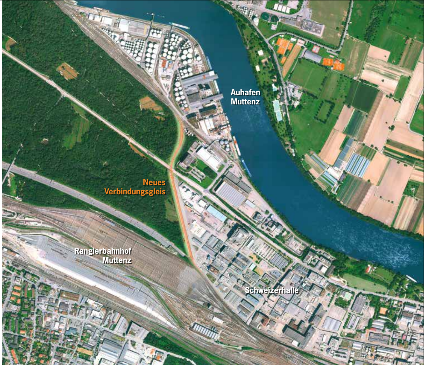
Das neue Verbindungs- gleis zwischen dem Auhafen und dem Rangier- bahnhof Muttensz
