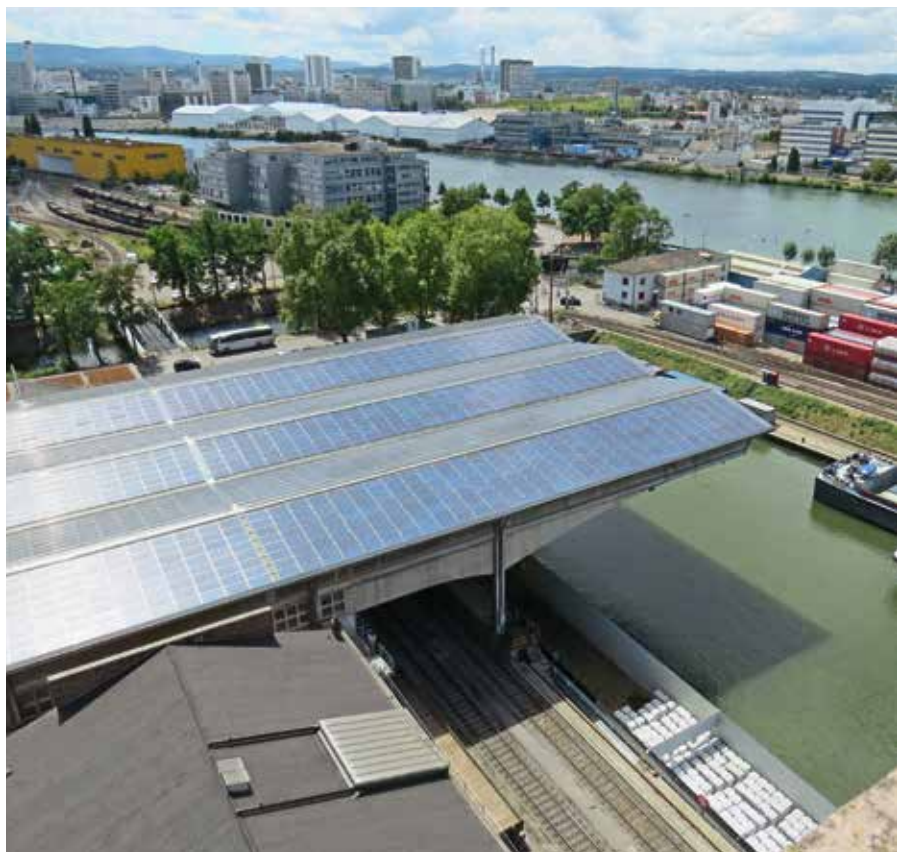
Solardach Rhenus Alpina AG im Stadthafen Kleinhüningen
