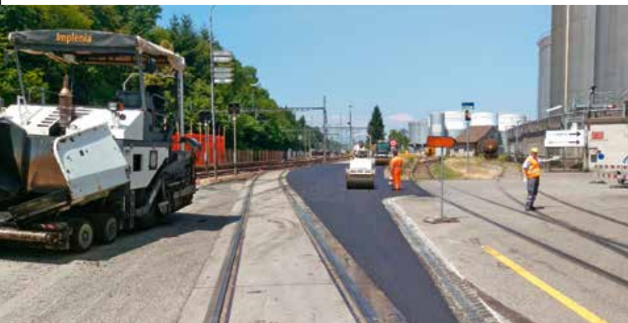
Belagsarbeiten Auhafenstrasse Muttenz abgeschlossen
