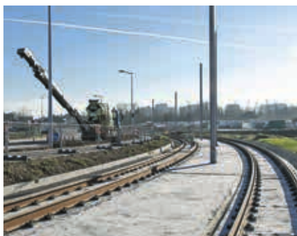
Mehr als 80 Prozent der Gleise sind gebaut.
