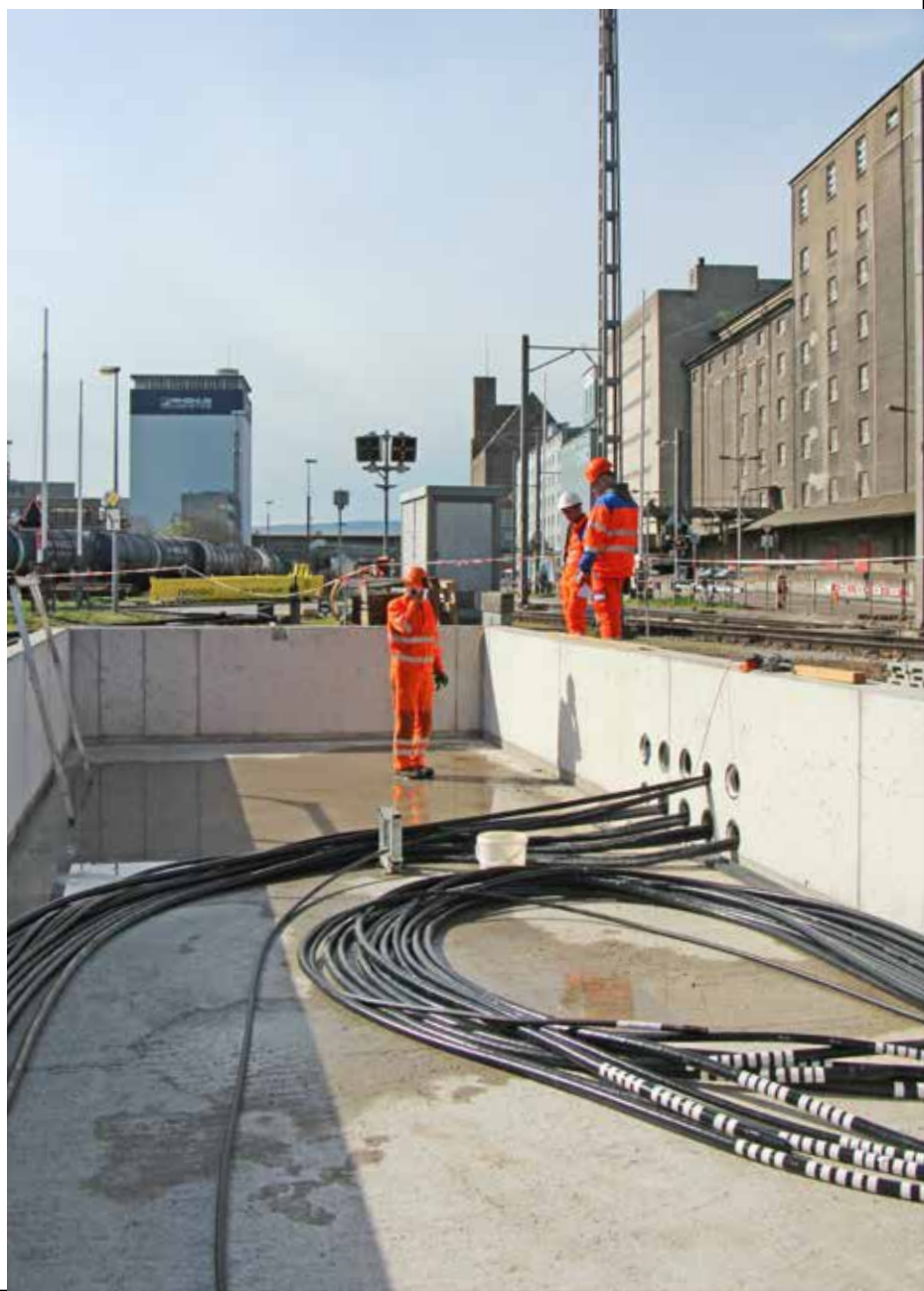
Fundament des neuen Stellwerks im Hafen Kleinhüningen
