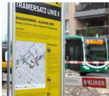
Die BVB-Baustellen sind neu signalisiert.
