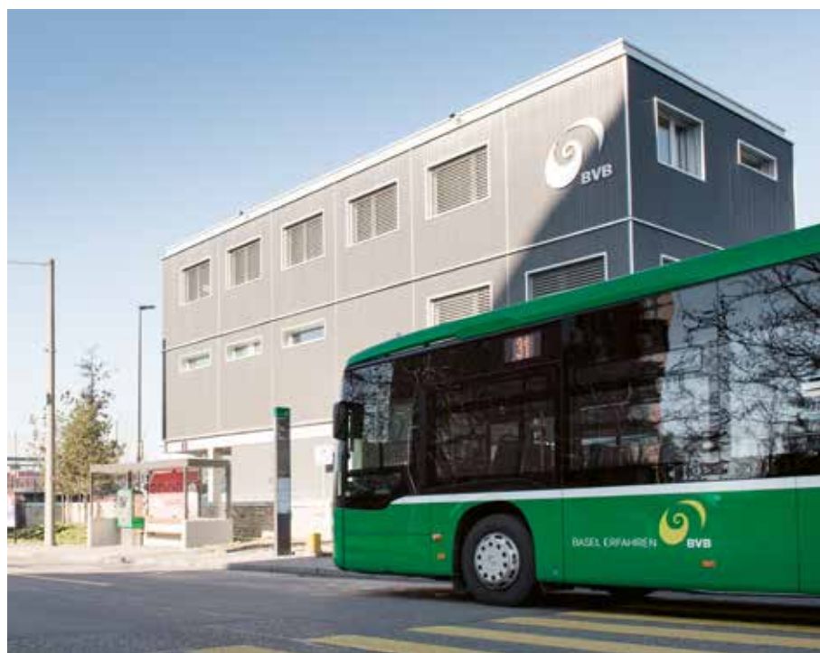
Der dreistöckige Neubau erfüllt den Minergie®-Standard.
