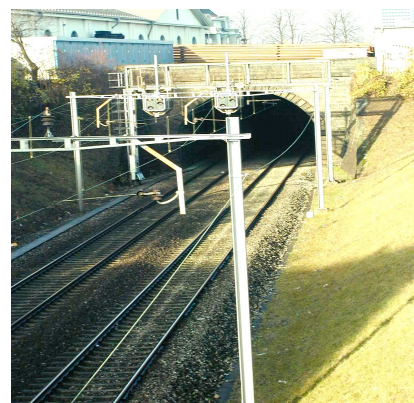
Blick von der Walkewegbrücke in Richtung Südportal Wolfstunnel und BVB-Depot
