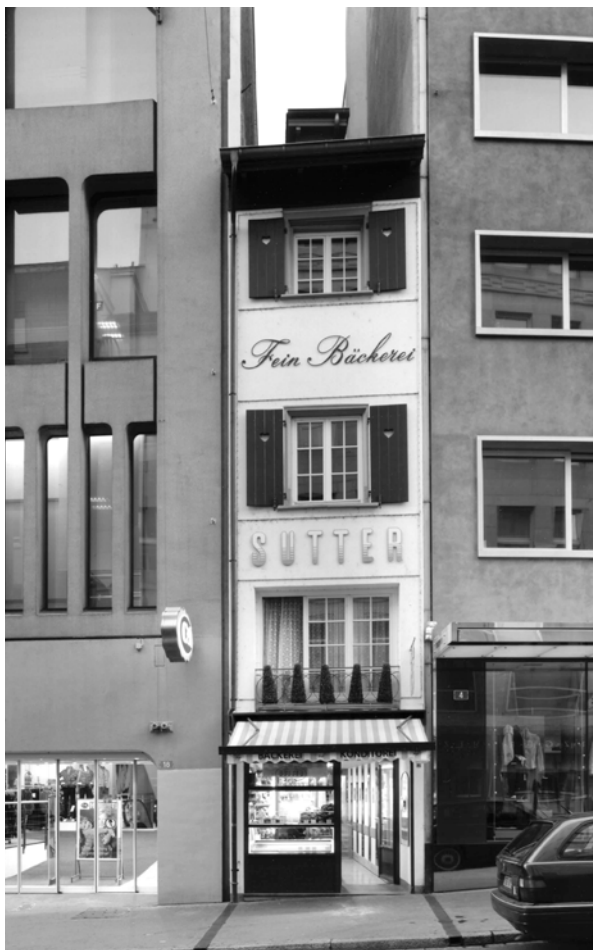
An der Streitgasse 8 blieb nach den Abbrüchen der 1960er Jahre nur ein schmales Altstadtthaus – eingeklemmt zwischen modernen Geschäftshäusern – stehen.
