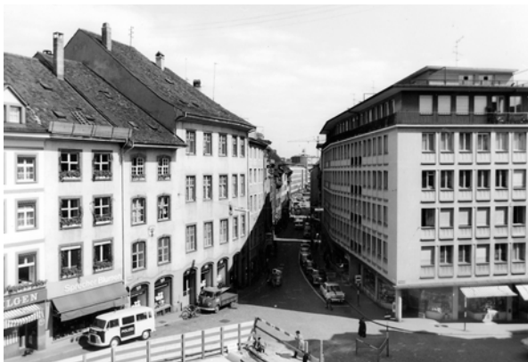
Die Altstadt Häuser auf der rechten Seite der Schneidergasse wurden für den Bau der sogenannten Talentlastungsstrasse abgebrochen und durch neue Geschäftshäuser ersetzt.
