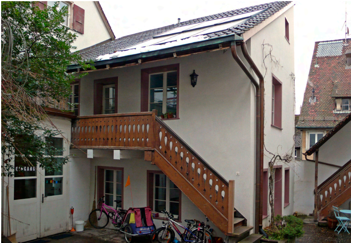
Das Hinterhaus Leonhardsberg 14 liegt in der Schutzzone und wurde mit einer thermischen Solaranlage versehen.
