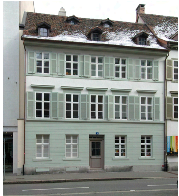
Das Haus Rebeggasse 5 wurde mit konventionellen Massnahmen energetisch saniert (Dämmung Keller, Estrich, Fensteraufrüstungen). Das Treppenhaus wurde als Kaltraum belassen.
