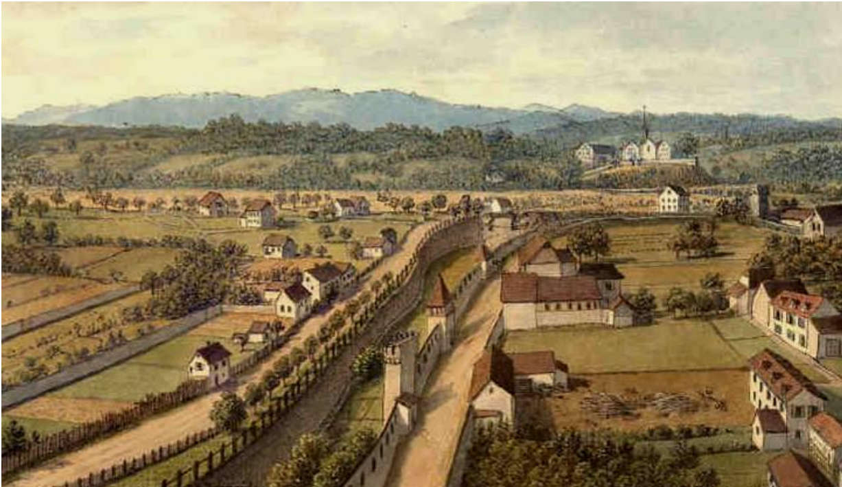
Abbildung 7: Der Aeschengraben um 1860 als Strasse entlang der Stadtmauer resp. dem Graben. Quelle: Staatsarchiv Basel-Stadt. Signatur: BILD Schn. 81
