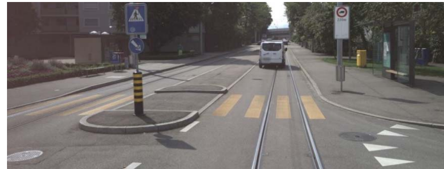
Adlerstrasse in Basel, HST Karl Bart-Platz, Beispiel für Kapphaltestelle
