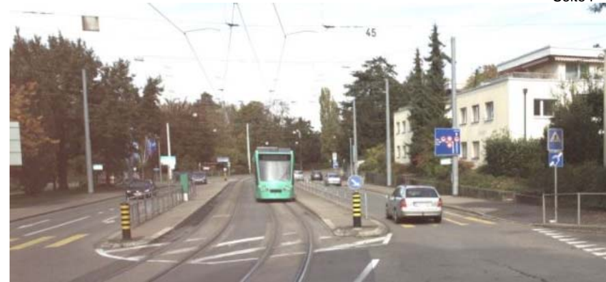
Lörcherstrasse in Riehen, HST Weilstrasse, Beispiel für Inselhaltestelle
