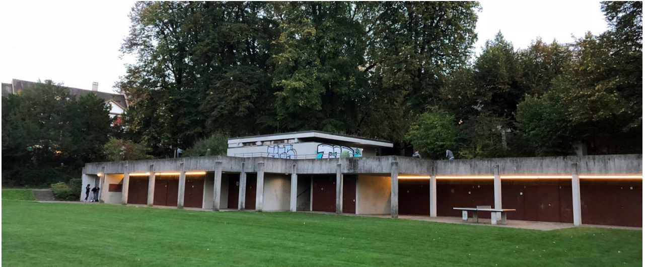
Abb. 4: Altes Garderobengebäude unterhalb Kunsteisbahn
