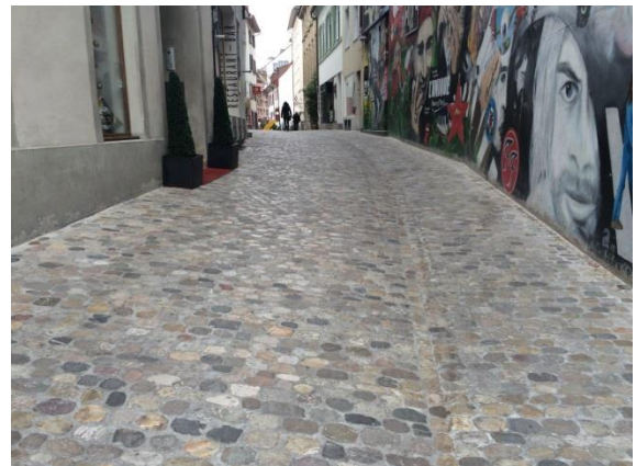
Gerbergässlein nach der Umgestaltung
