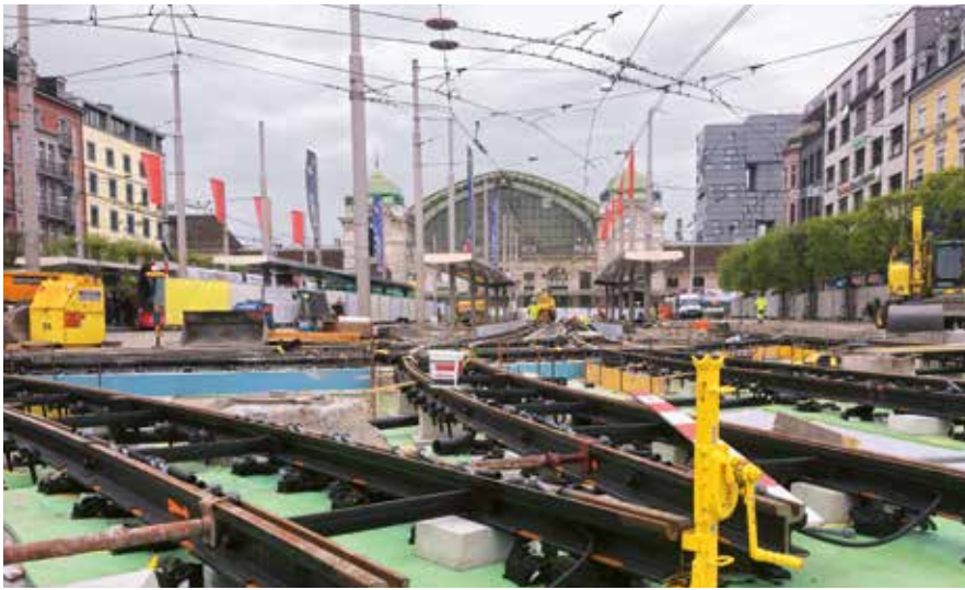
Nach bis zu 19 Betriebsjahren wurden Schienen und Kreuzungen am Centralbahnplatz ersetzt.
