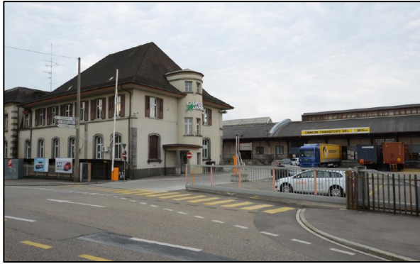
Abb. 6: Dienstgebäude und Güterhallen
