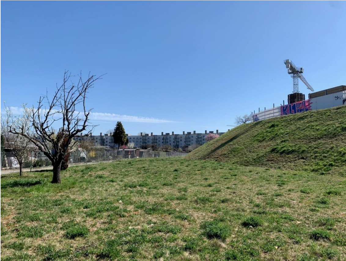
Abb. 4: Geräumtes Areal 2021 (Hangkante = Landschaftsschutzgebiet) und Baustelle Wohnüberbauung Burgfelderstrasse
