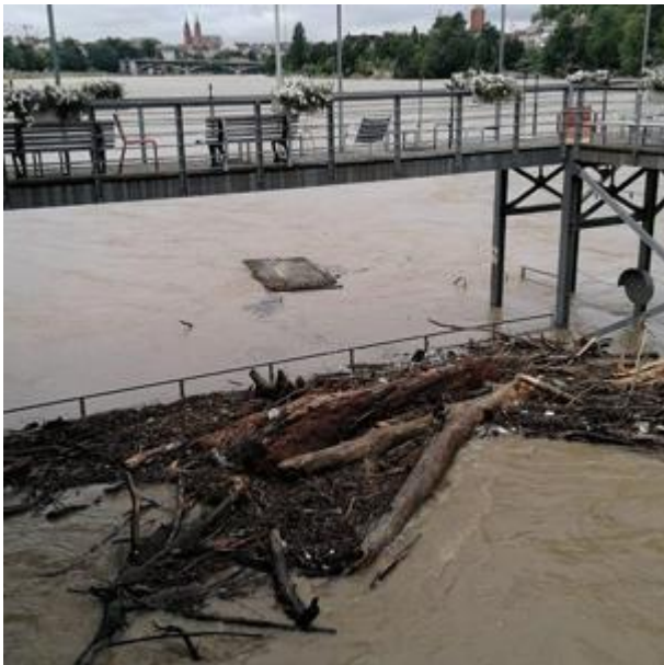
Angestautes Schwemmholt kann zu sehr hohen Wasserdrücken auf die Infrastruktur führen.
