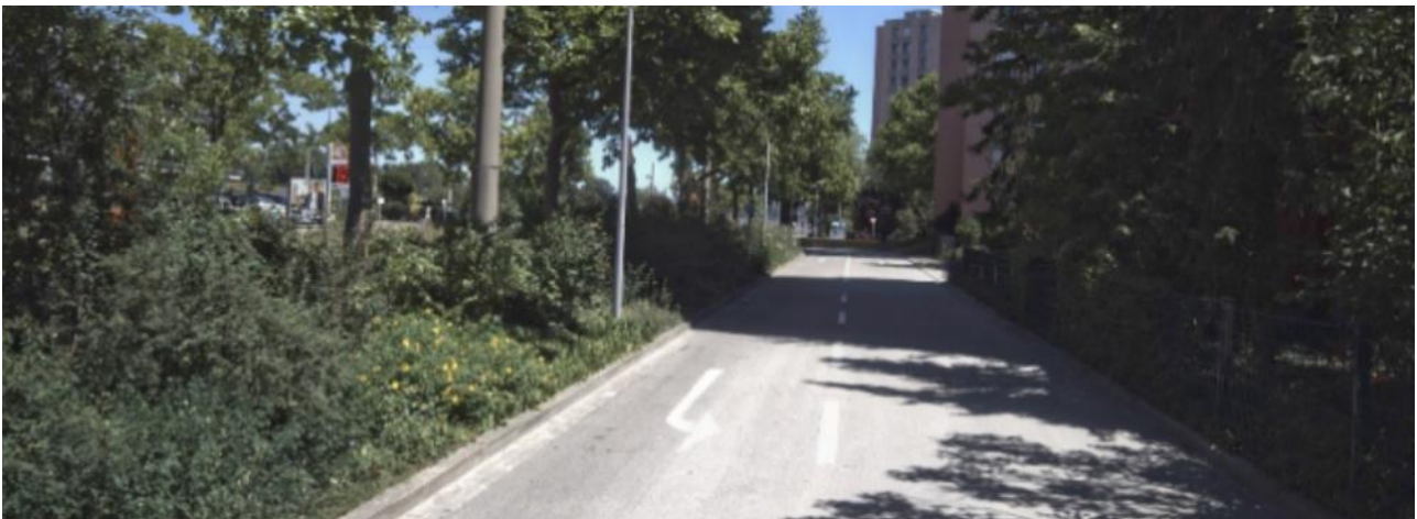
Abbildung 4: Nebenfahrbahn Grenzacherstrasse Blickrichtung Im Grenzacherhof, kein Trottoir vorhanden
