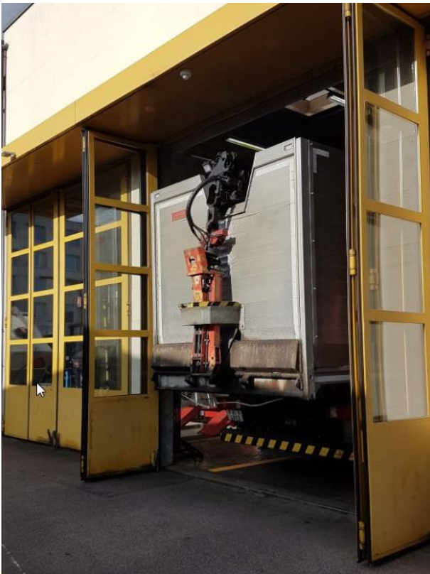
Abb. 12: Ungenügende Gebäudetiefe «Werkstatt schwer»: Das Tor kann nicht geschlossen werden. Das Fahrzeug kann nicht angehoben werden.
