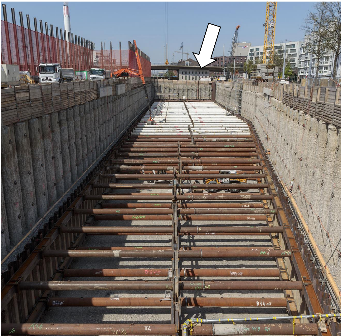
Abbildung 3: Baugrube Neubau NMB&StABS am 25.4.2022, Blickrichtung Luzernerringbrücke/Widerlagergebäude. Foto: Derek Li Wan Po
