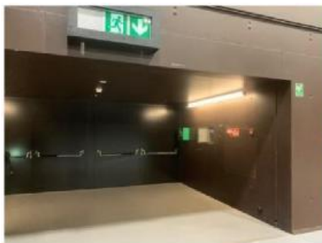
Abb. 72: Türen zu Foyer Halle 3
