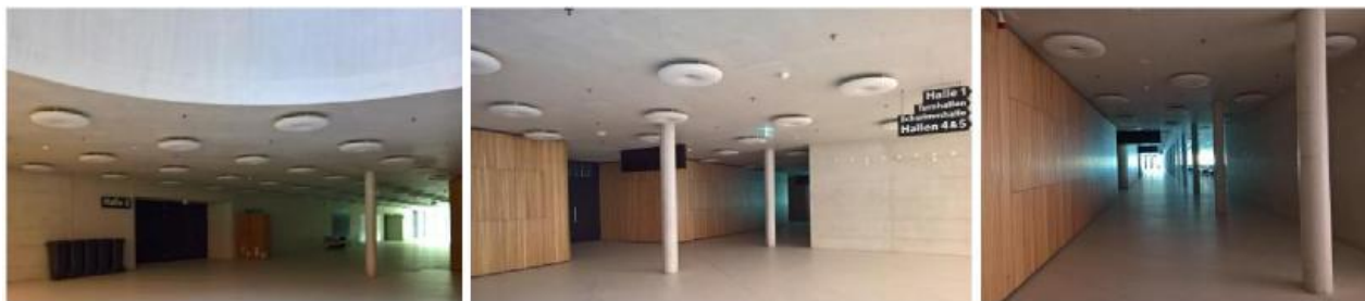
Abb. 51–53: Foyer 1. OG im nördlichen Bereich
