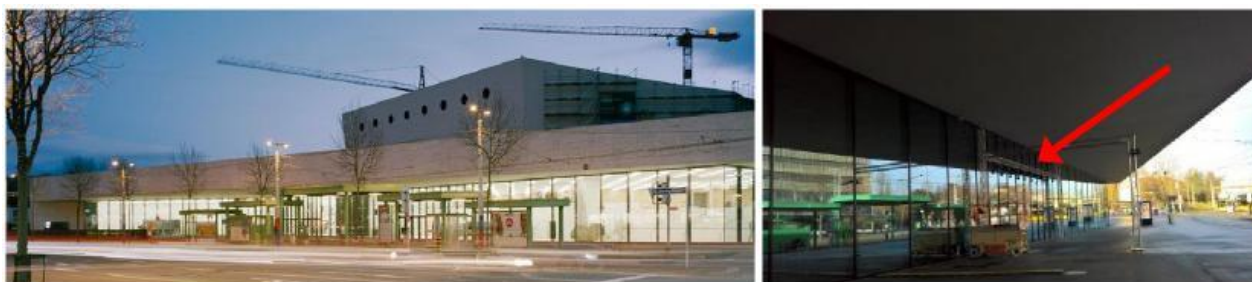
Abb. 35 u. 36: Ist-Situation bei Dämmerung, provisorischer Beleuchtungssituation unter Vordach
