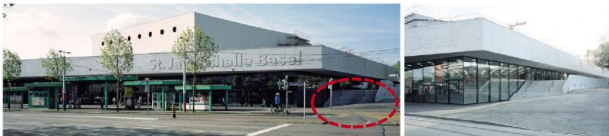
Abb. 37 u. 38: Nordseite St. Jakobshalle mit Aussentreppe
