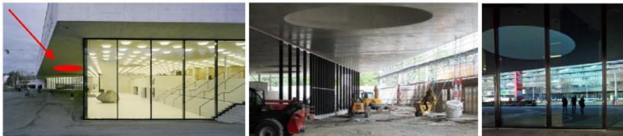
Abb. 41-43: Vorplatzbereich mit Dachöffnung über Eingangsbereich
