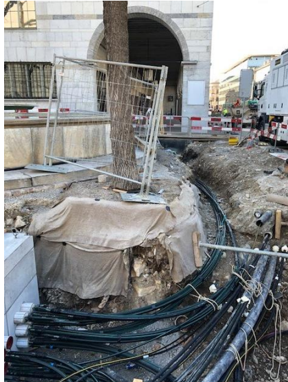
Beispiel Leitungsführungen in der Nähe von Bestandsbäumen
