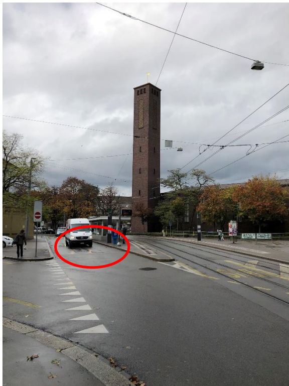
Abb. 4: Die künftig aufgehobene Fahrbahn
