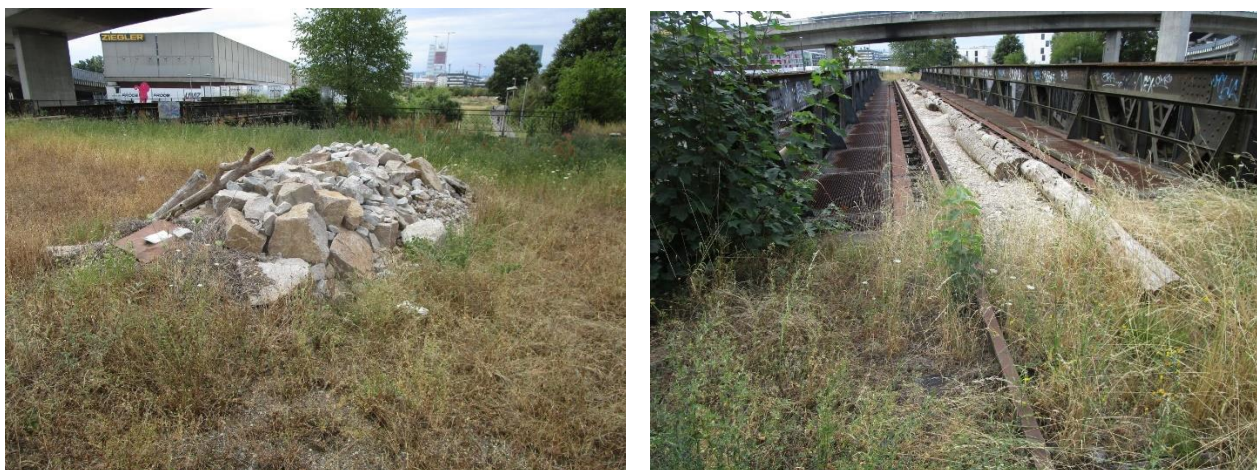
Abb. 20 und 21: Brückenplateau und Grünbrücke der DB AG mit realisierten Massnahmen durch die DB AG
