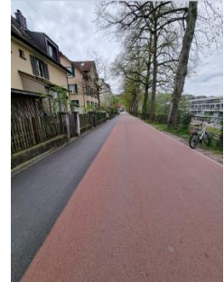
Abbildung 7: Roteinfärbung Belag Winterthur
