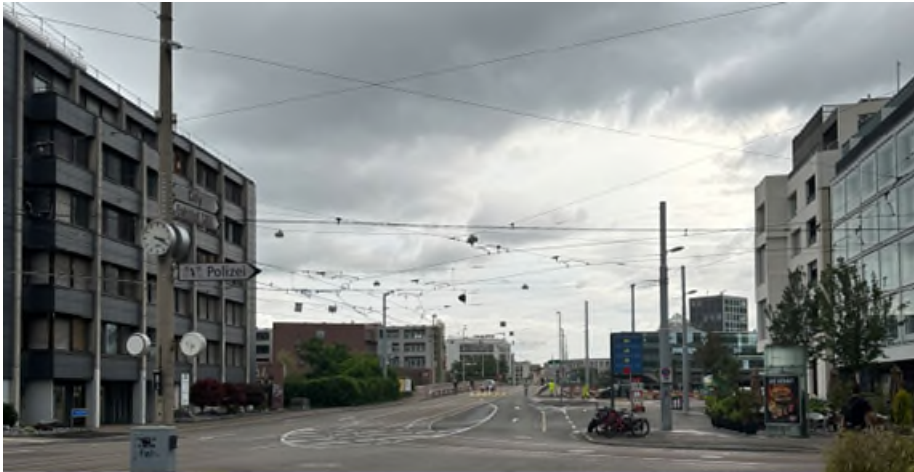
Links im Bild: Beleuchtungsmast IWB und Steuerungskasten Swisscom (auf Insel der Haltekante B)
