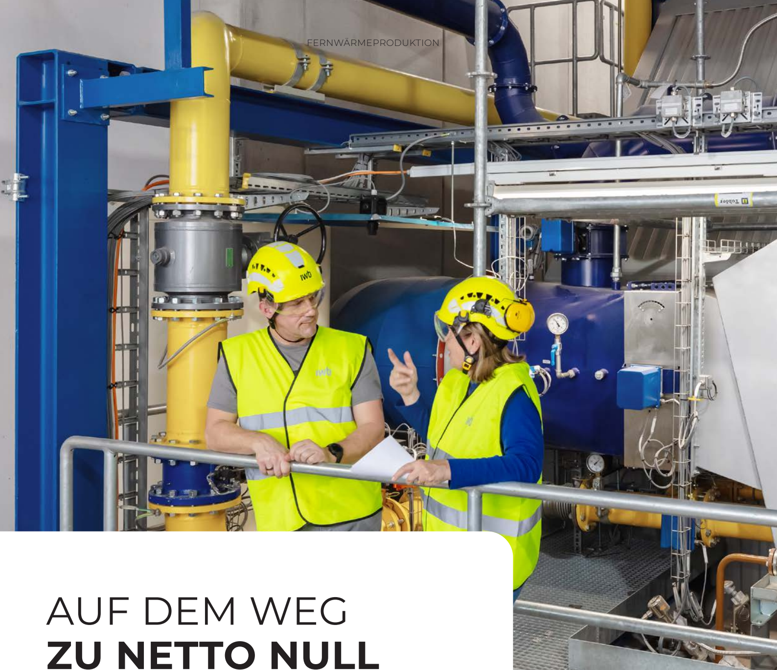
Im Fernheizkraftwerk Volta hat IWB einen neuen «Multifuel»-Dampfkessel eingebaut.
