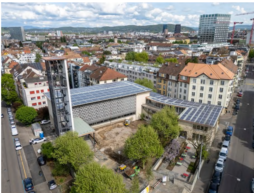
Abb. 1 Solaranlage auf der Johanneskirche (Schutzobjekt)
