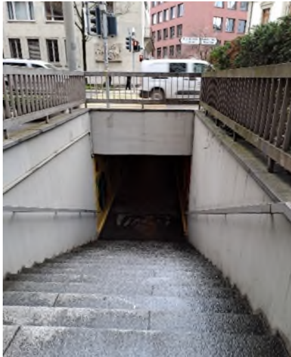
Abb. 1: Unterführung Steinengraben, Zugang, UF12 (Eingangsportal mit Treppe)
