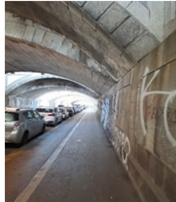
Abb. 6: Unterquerung Maulbeerstrasse, UF47
