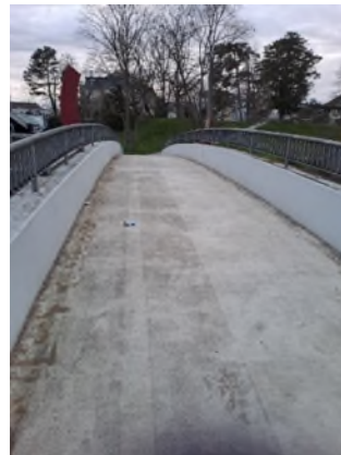
Abb. 9: Fussgängerbrücke Brüglingerstrasse, ÜF50
