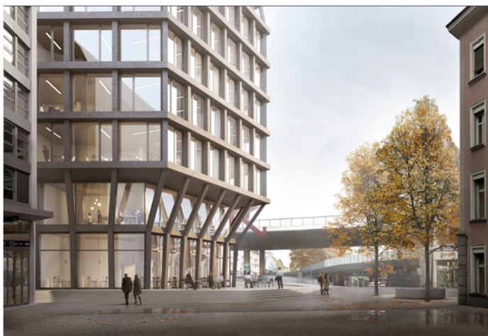
Hochhaus Heuwaage (Miller Miranta)
