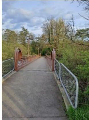
Abb. 8: City-Ring Fussgängerbrücke, ÜF49
