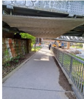
Abb. 5: Unterquerung Wiesendamm-Promenade (nahe Freiburgersteg, südseitig), UF41B
