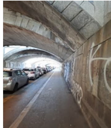
Abb. 6: Unterquerung Maulbeerstrasse, UF47
