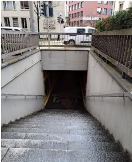
Abb. 1: Unterführung Steinengraben, Zugang, UF12 (Eingangsportal mit Treppe)
