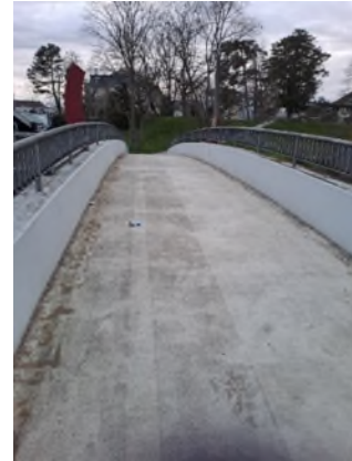
Abb. 9: Fussgängerbrücke Brüglingerstrasse, ÜF50
